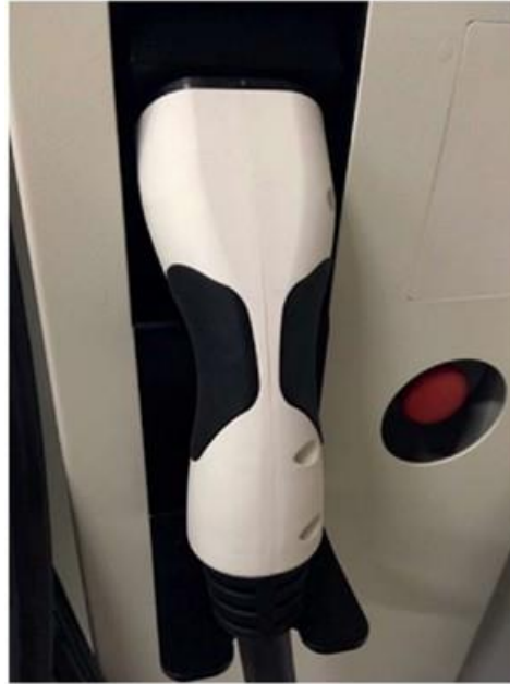
AC-Ladekabel, 22kVA / 43kV, Mode 3, Typ 2
