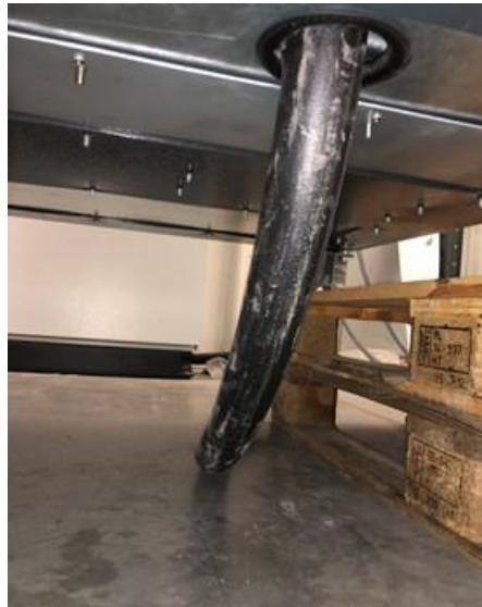
Bild 6-3 Ansicht Kabel von unten durch die Kabeldurchführung CPC 50/60/90/120
