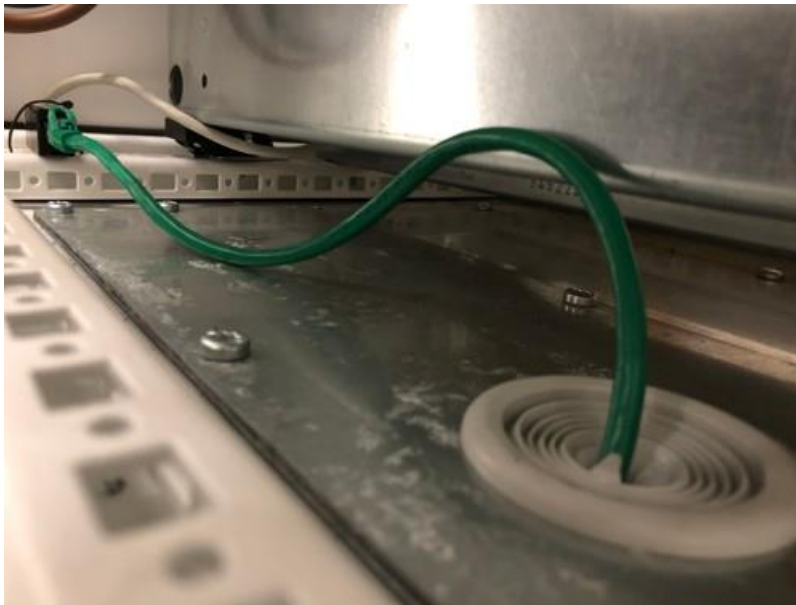
Bild 6-11 Ethernet-LAN-Netzwerkabel nach der Bodendurchführung
