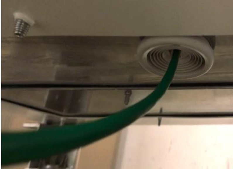
Bild 6-10 Ansicht Ethernet-LAN-Kabelanschluss Kabel von unten durch die Kabeleinführung
