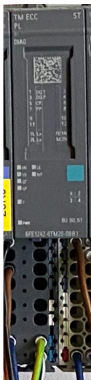
Bild 9-6 Braunes Kabel links lösen
